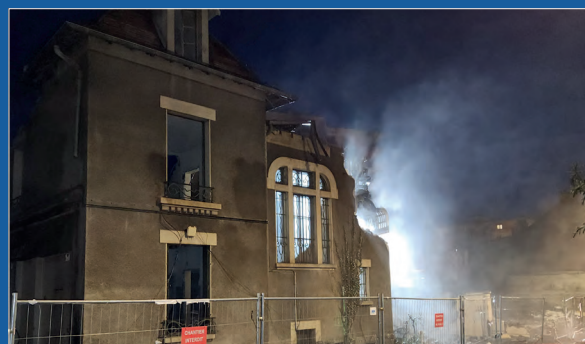
Démolition des anciens bâtiments.
