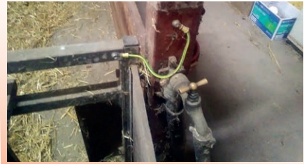
Relier un abreuvoir à la terre est souvent simple et efficace. Photo : Robustagno
