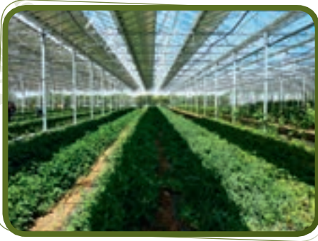
Zones d'ombre provoquées par les panneaux en toiture
