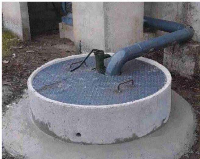
Afin d'éviter toute pollution de nappe, une margelle bétonnée doit être réalisée de manière à éloigner les eaux de la tête de forage. Cette margelle est de 3 m<sup>2</sup> au minimum autour de la tête et de 0.30m de hauteur au-dessus du niveau de terrain naturel. Elle n'est pas obligatoire lorsque la tête du forage est dans un local. La tête du forage doit s'élever au moins à 0.50 m au-dessus du sol.
