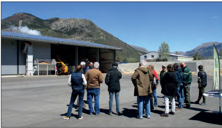
La « fumée » qui s'échappe de l'unité de fabrication est composée uniquement de vapeur d'eau issue du processus de séchage de la sciure et des plaquettes avant la mise sous presse.
